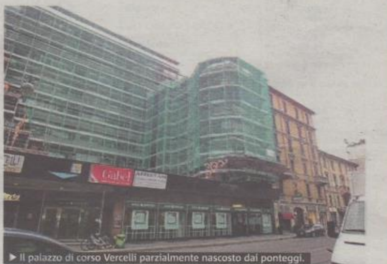
► Il palazzo di corso Vercelli parzialmente nascosto dai ponteggi.
